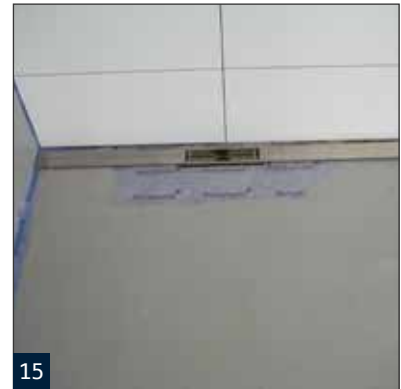
Nachträgliche Kontrolle der Ausrichtung von Water LD V.
