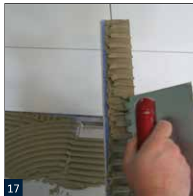
Auftragen von Fliesenkleber auf der Profil Rückseite.
