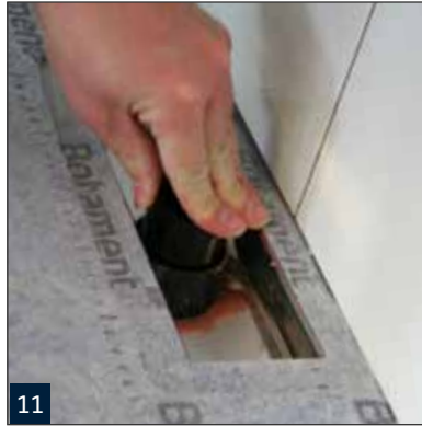
Einsetzen des Geruchsverschlusses.
