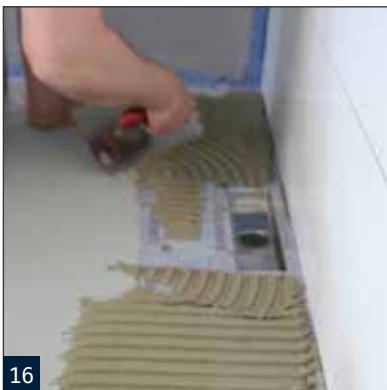
Auftragen von geeignetem Botament Fliesenkleber.
