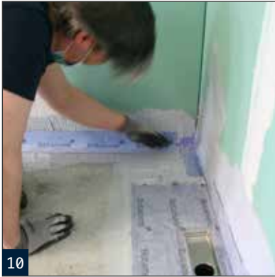
Einarbeiten der SB78 Dichtbänder in Multiproof.
