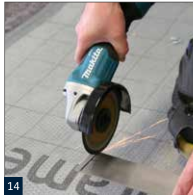
Variablen schneiden der Water LD V mittels langsamlaufender Flex mit entsprechenden geeigneten Flexscheibe.
