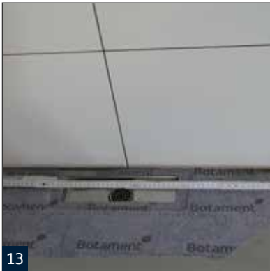
Ausmessen der erforderlichen Länge.
